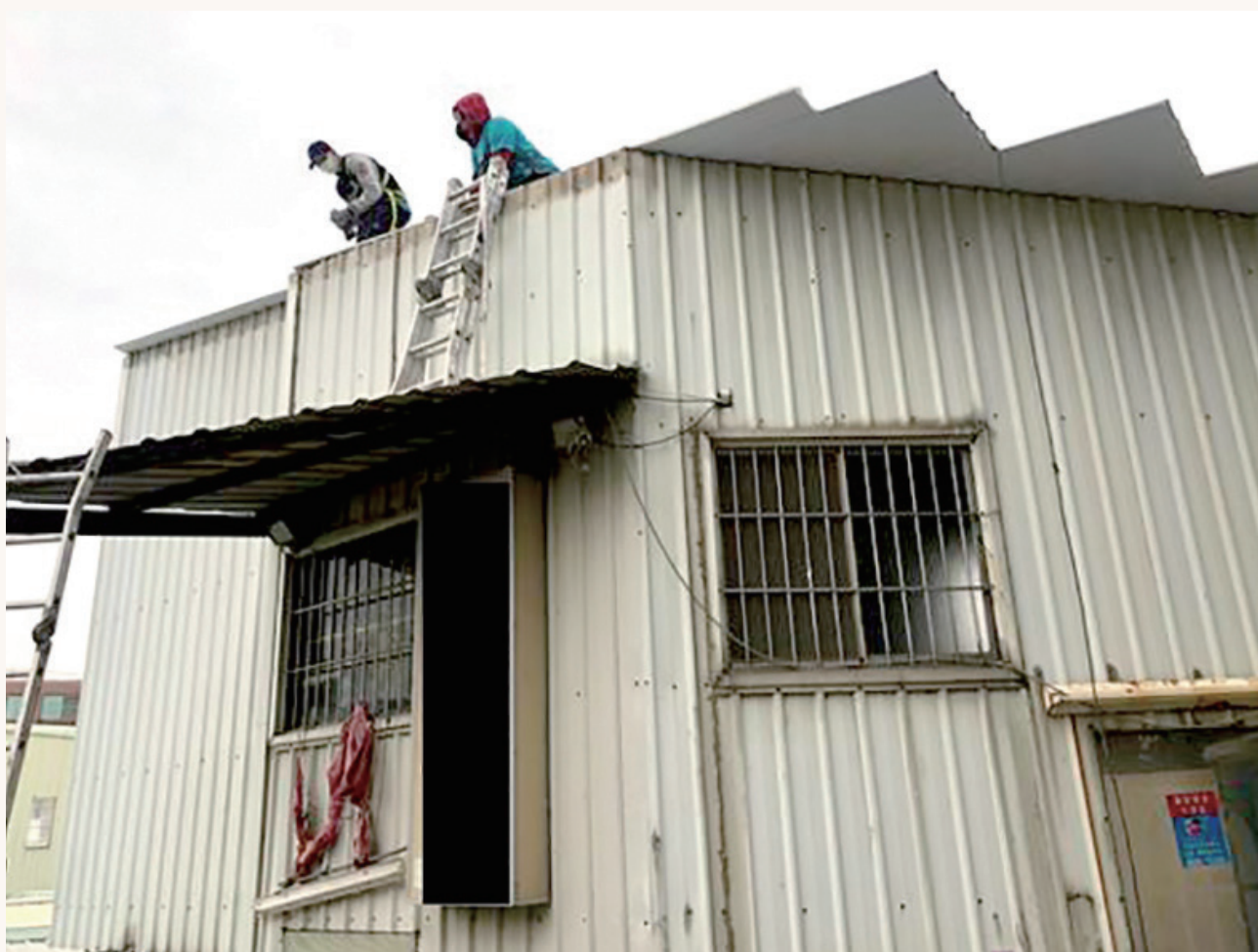
圖：衡山基金會提供個案屋頂漏水修繕工程
