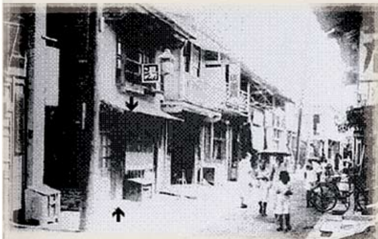
圖4. 1885年在府城看西街亭仔腳找到的房子(箭頭所指處)，設立台灣第一個佈道所及西醫醫館。(謹謝新樓醫院供給)
